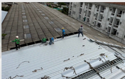
รื้อหลังคาเก่า พร้อมติดตั้งหลังคาใหม่
